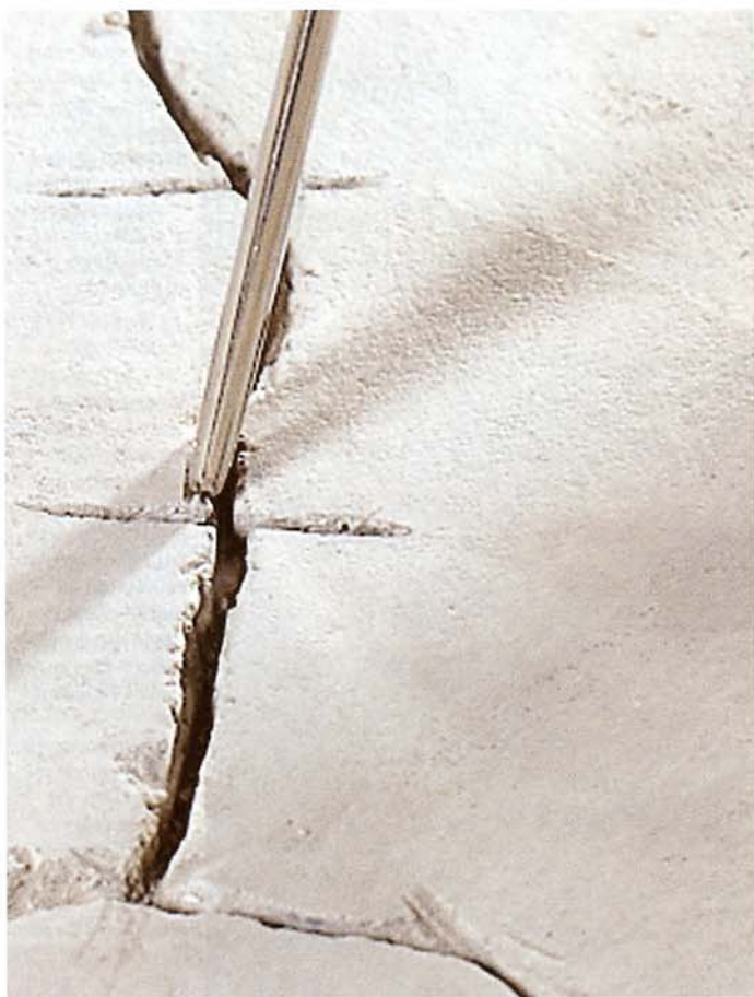
■ Gerissener Zementestrich mit eingefrästen Fugen für die Quervernadelung.
