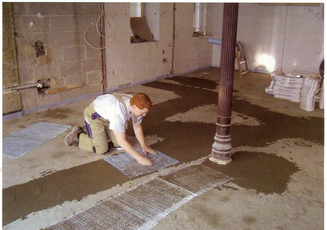
■ Überbrückung der verfüllten Kanäle und Schwachstellen mit gerichteten Glasfaserarmierungssträngen.
