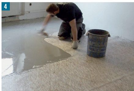
4 Glastextilarmierung einer fünf Millimeter dicken Ausgleichsspachtelung auf Holzparkett zur Aufnahme eines elastischen Belags in Räumen eines Kasernengebäudes. Die auf der getrockneten Grundierung ausgelegten Bahnen der CS-Matte wurden in den Fließspachtel eingebettet. Der Fließspachtelmasse waren bis zu zwölf Millimeter lange Kurzglasfasern beigemischt.
