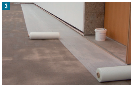
4 Glastextilarmierung einer fünf Millimeter dicken Ausgleichsspachtelung auf Holzparkett zur Aufnahme eines elastischen Belags in Räumen eines Kasernengebäudes. Die auf der getrockneten Grundierung ausgelegten Bahnen der CS-Matte wurden in den Fließspachtel eingebettet. Der Fließspachtelmasse waren bis zu zwölf Millimeter lange Kurzglasfasern beigemischt.
