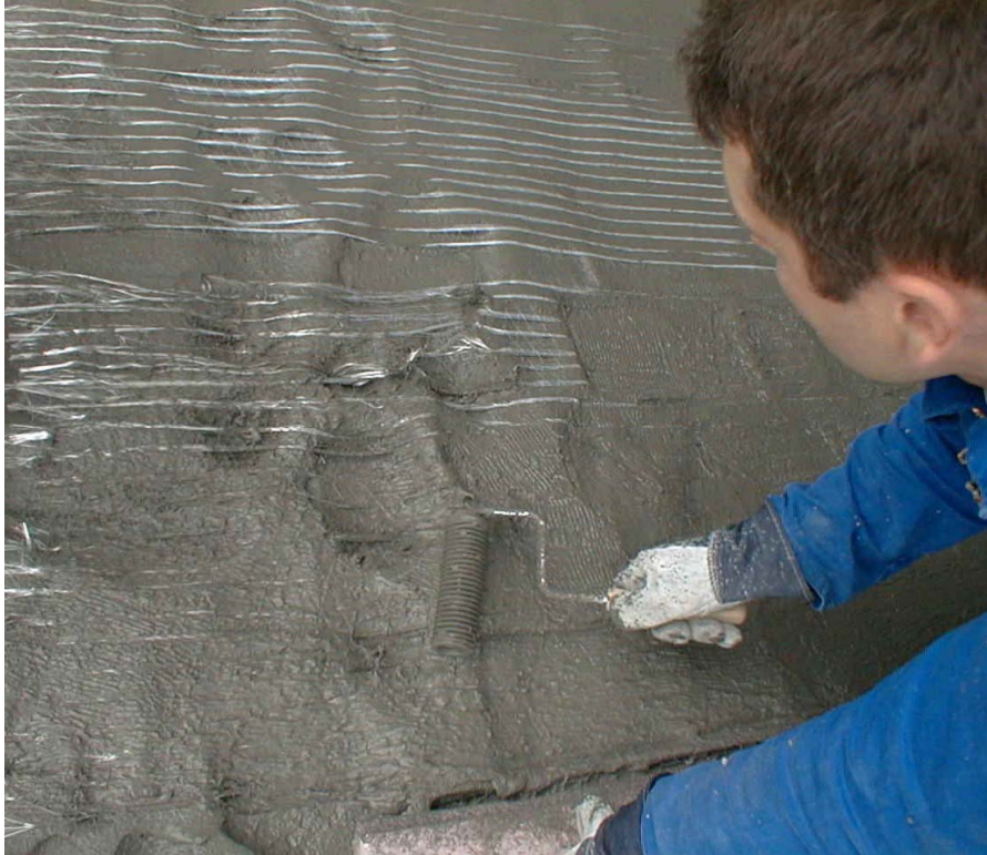
Bild 3: Unidirektionales Gelege bei Handfertigung
